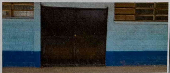
Foto 6: Las puertas se encuentran en mal estado, por lo cual se van a reparar y le realizara cambio de chapas.
